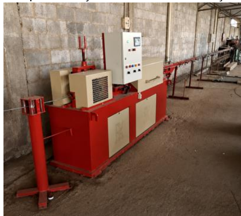
Figura 3 – Máquina após a implementação do retrofit e instalação das medidas de proteção.
