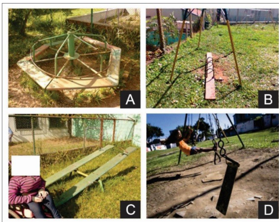
(A) Carrossel mal conservado, com pintura descascada e quebrado (B) Trenzinho quebrado (C) Gangorras com suporte para as mãos quebradas, com farpas em toda a superfície e pintura descascando. Fonte: Dos autores. (D) Balanço quebrado.
